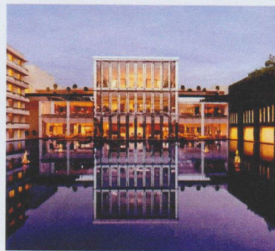
Ruhependende Architektur, Wasserinstallationen – und dies mit 100 Prozent Solarenergie!
