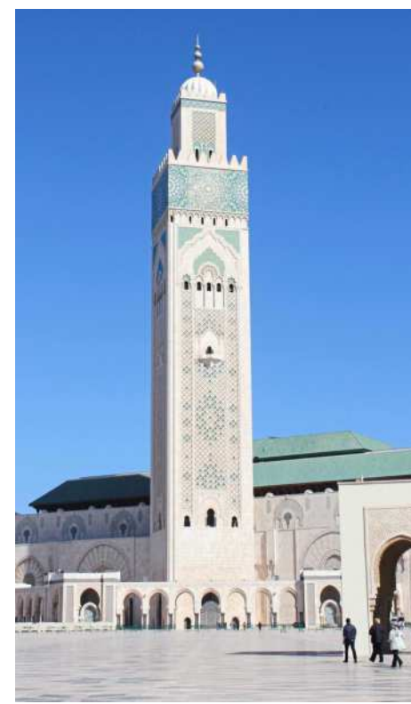
Hightech: Die „Cabrio-Moschee“ in Casablanca, zweitgrößte Moschee Afrikas, hat Fußbodenheizung und Schiebedach.
